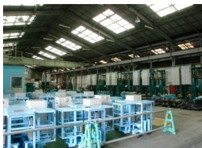
重量物吊上げ装置 作動試験
