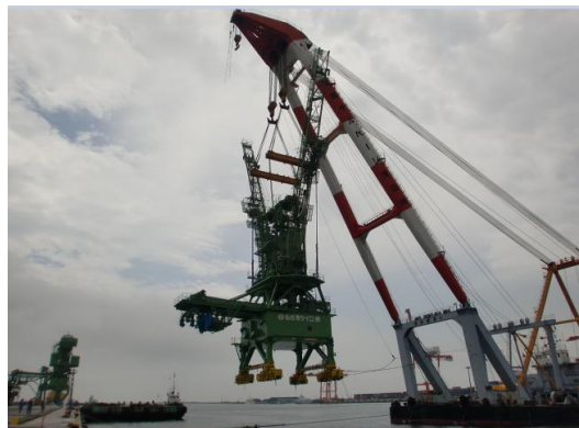
フローティングクレーンによる水切り作業
