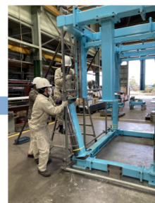
上部フレームに柱組立、下部フレーム取合い
