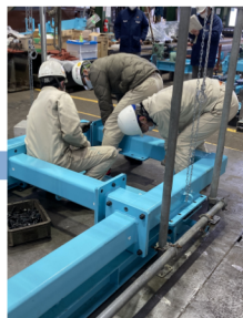
上部フレーム組立
