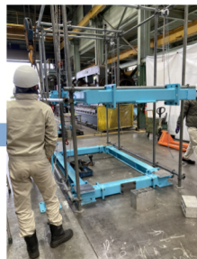
上部フレーム吊上げ
