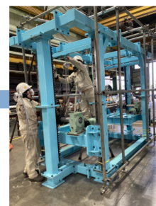
下部昇降フレーム組立
