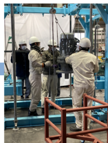
鋸刃駆動モータ取付
